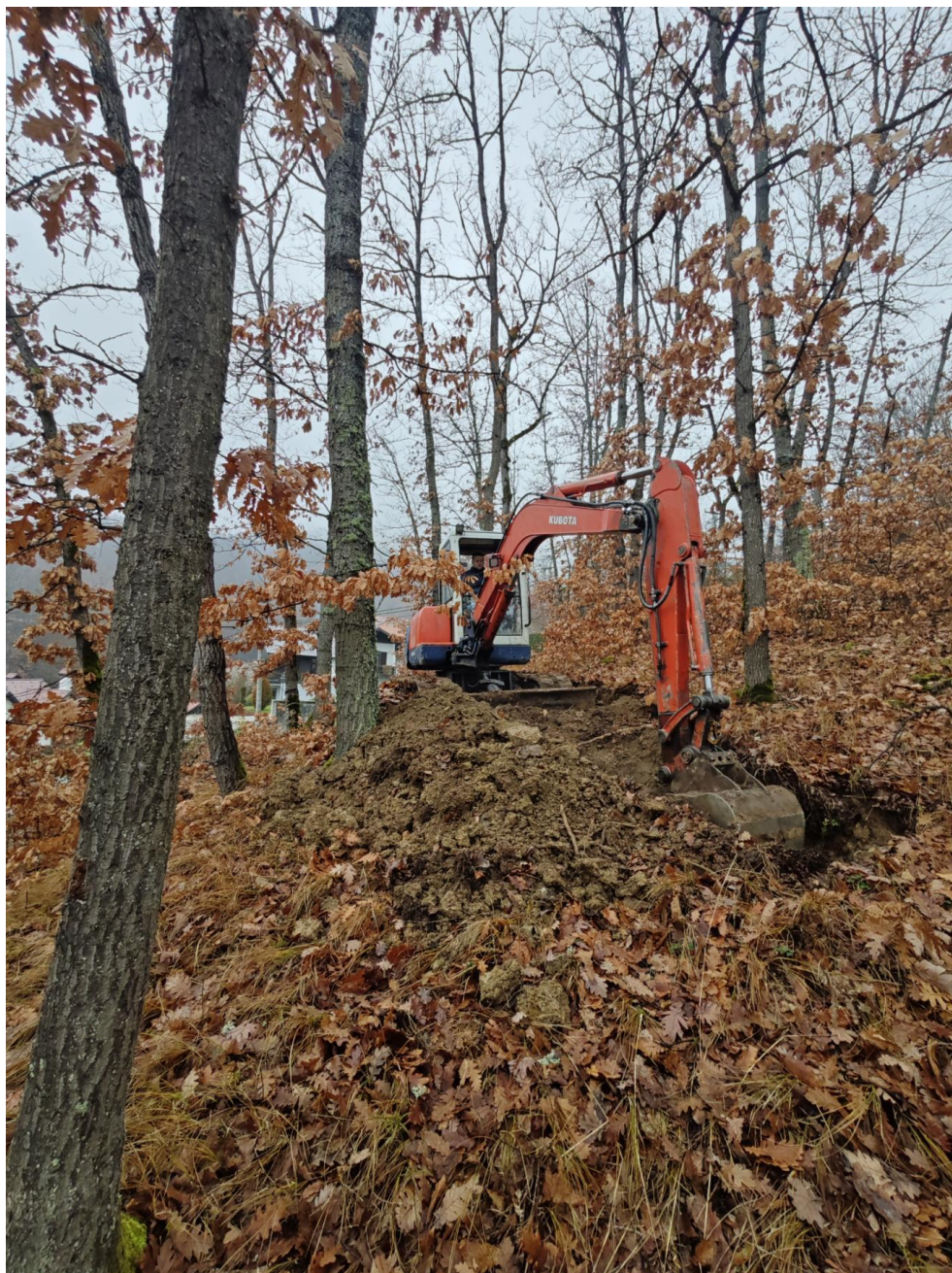
Slika br. 3- Izvođenje istražnih jama
